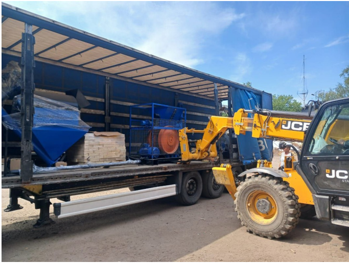
Entladen der Anlage in der Stadt Kramatorsk
